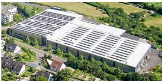
BITO Meisenheim – Instalacja fotowoltaiczna
