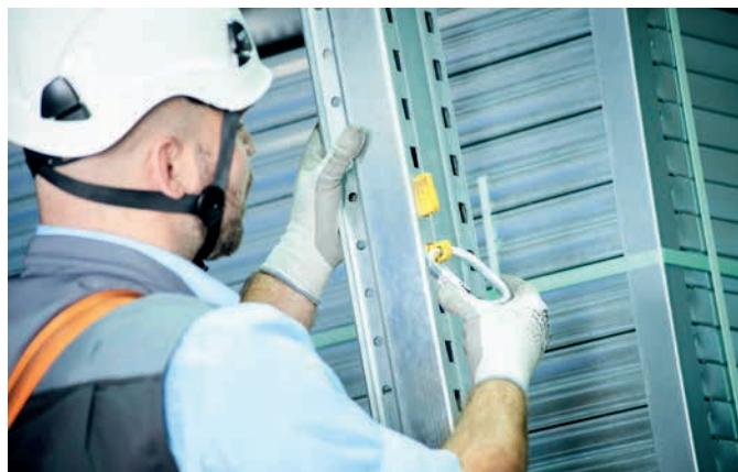
1. Selezionare un punto di ancoraggio sicuro per fissare il BITO easyHOOK e agganciare il moschettone con chiusura a vite
