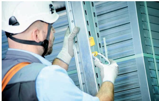
1. Choisissez un point d'ancrage sûr pour accrocher le BITO easyHOOK et verrouillez-le avec le mousqueton Twistlock.
