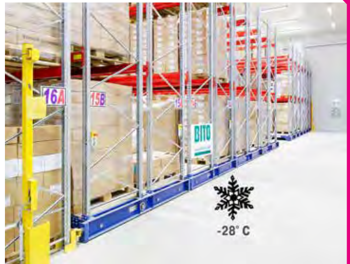
Paletten-Verfahrregalanlage im Tiefkühlbereich
