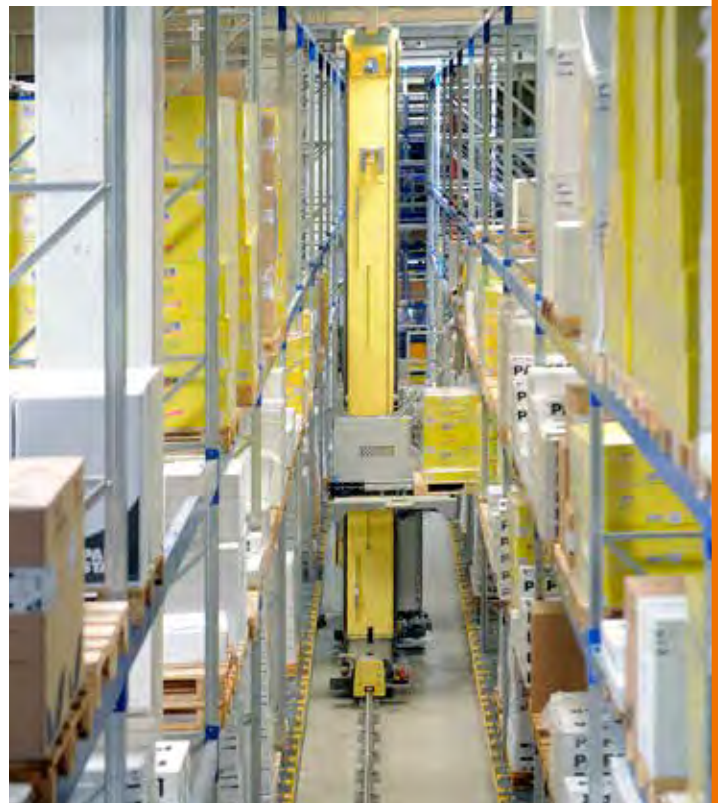
Papstar, Einlagerung von Paletten. In der untersten Ebene werden die Paletten in Durchlaufkanäle zur Bereitstellung für den Kommissionierbereich eingelagert.
