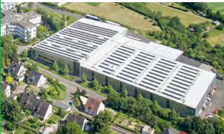
BITO Meisenheim – Photovoltaikanlage
