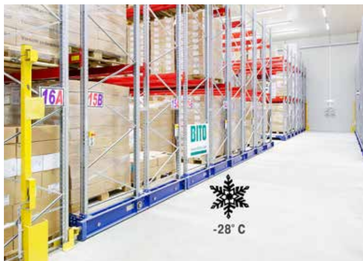
Rayonnages à palettes mobiles, entrepôt pour produits surgelés
