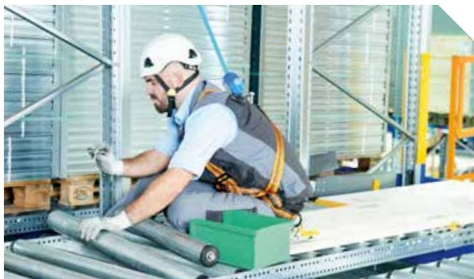
Le kit d'accès permet également d'effectuer facilement et en toute sécurité des travaux de réparation, comme le remplacement de rouleaux porteurs et de rouleaux freins dans le système de rayonnages. Une fois le couloir vidé, l'employé sécurisé peut accéder directement au couloir dans lequel les planches ont été installées à l'aide d'une nacelle de maintenance.
