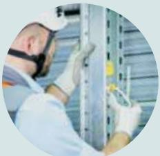
1. Assurez-vous en fixant le crochet d'amarrage easyHOOK et en y accrochant le mousqueton Twistlock.
