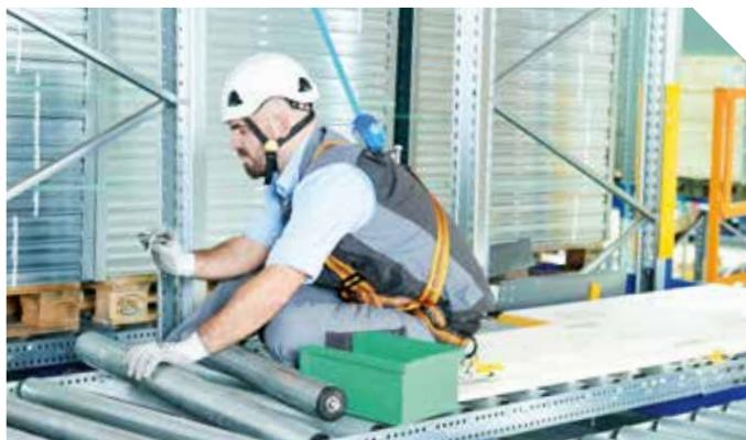
Auch Reparaturarbeiten, wie z. B. der Austausch von beschädigten Trag- oder Bremstragrollen im Regalkanal, lassen sich leicht und sicher ausführen. Nachdem der Kanal geleert wurde, kann der abgesicherte Mitarbeiter via Wartungskorb direkt in den mit Brettern ausgelegten Kanal einsteigen.
