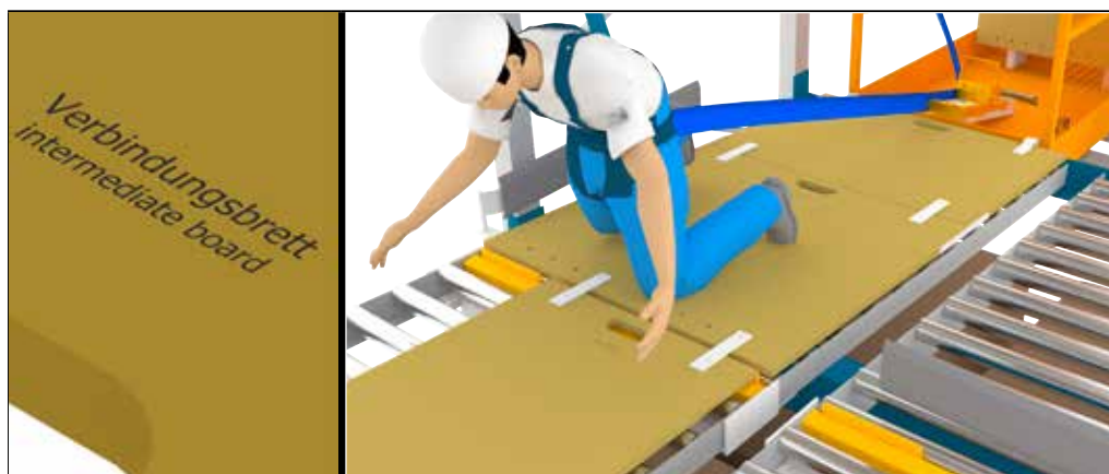
Bild 18: Sammankoppling av förbindningsplanet och passplanet.
