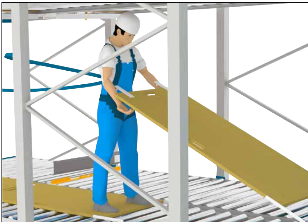
Bild 19: Utläggning av förbindningsplan.
