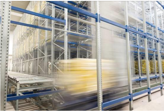
Bild 5: Das Regalbediengerät an der Anlagerückseite lagert die Paletten automatisch in das Regal ein.
