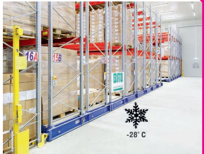
Paletten-Verfahrregalanlage im Tiefkühlbereich
